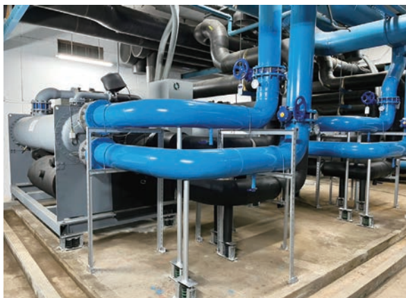
2 臺大型冰水主機更新汰換後，有效提升中央空調效率並降低用電量
