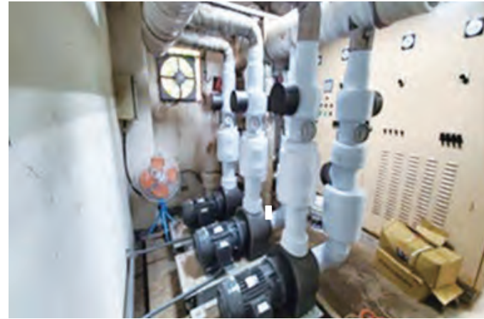
良師園空調水泵更換
